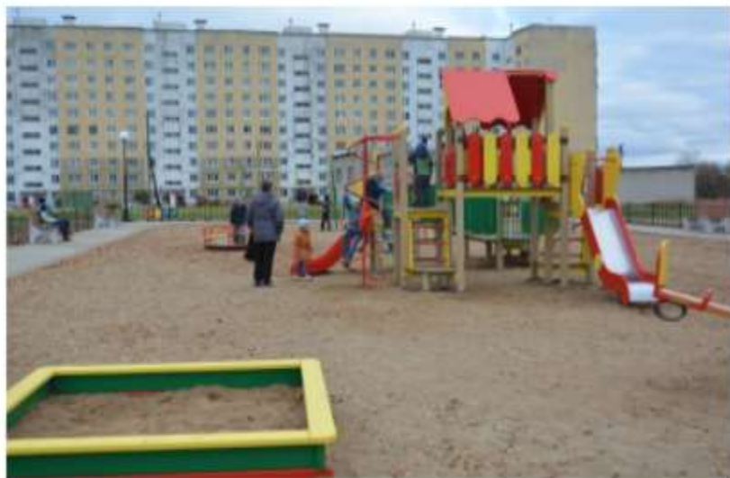
Строительство детской игровой площадки в п.Голынки Руднянского района Смоленской области
